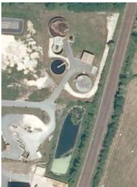
Station d'épuration (Commune de Saint-Médard-de-Mussidan)
