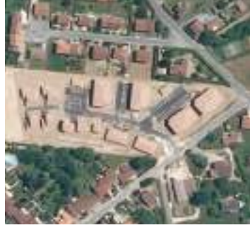
Opération d'habitat groupé : 46 logements
